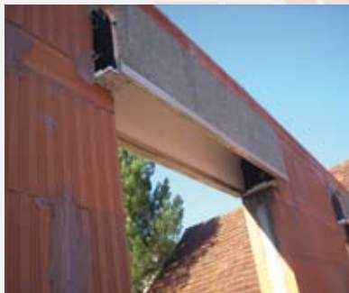
coffre tunnel vue intérieure avant doublage
