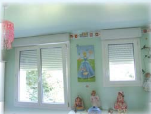
vue intérieure d'une fenêtre avec VRI en rénovation
